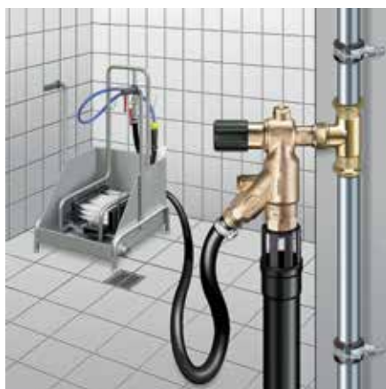
Tilslutning af et støvlewaskeanlæg med KEMPER FK-4. Anvendelse iht. DIN 1988, del 100, tabel A1, anvendelsestilfælde nr. 55.
