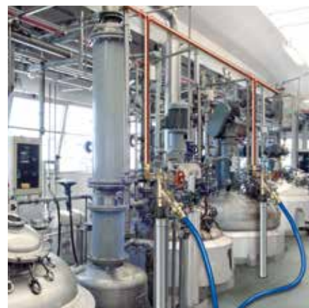
Tilslutning af kemisk rengøringsudstyr med KEMPER FK-4. Anvendelse iht. DIN 1988, del 100, tabel A1, anvendelsestilfælde nr. 10.
